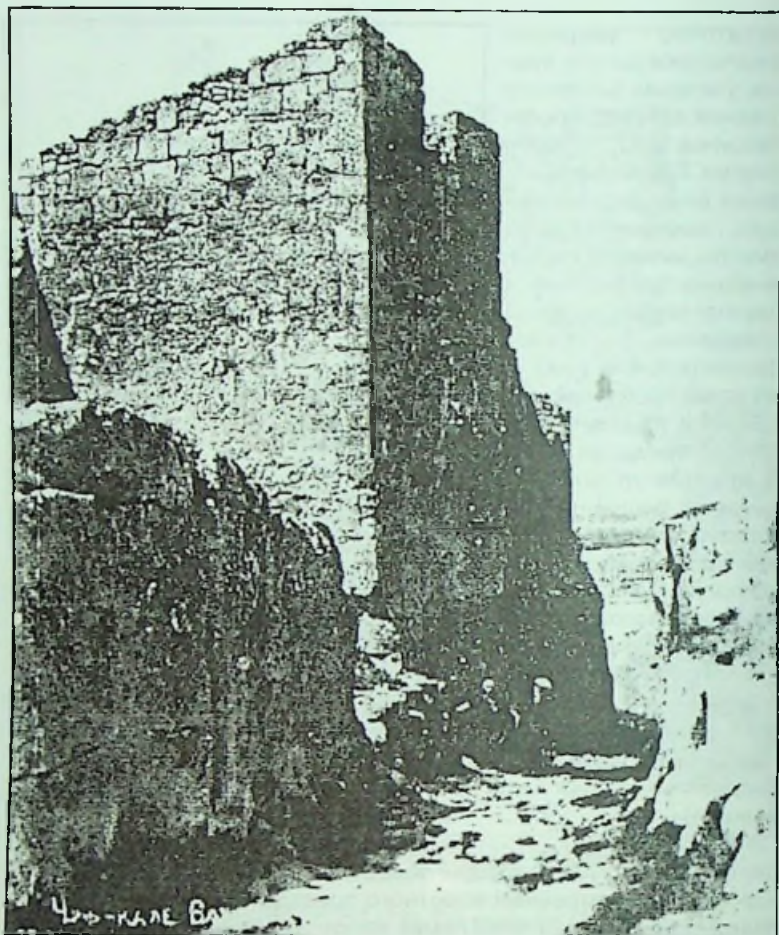
Рис. 12. Чуфут-кале. Ров и башня между северной и центральной куртинами. Вид с юго-востока. Фото 20-х гг. XX в.
